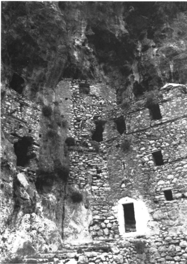
Εικ. 5. Άποψη των κατασκευών στον βράχο από τα ΒΔ.
