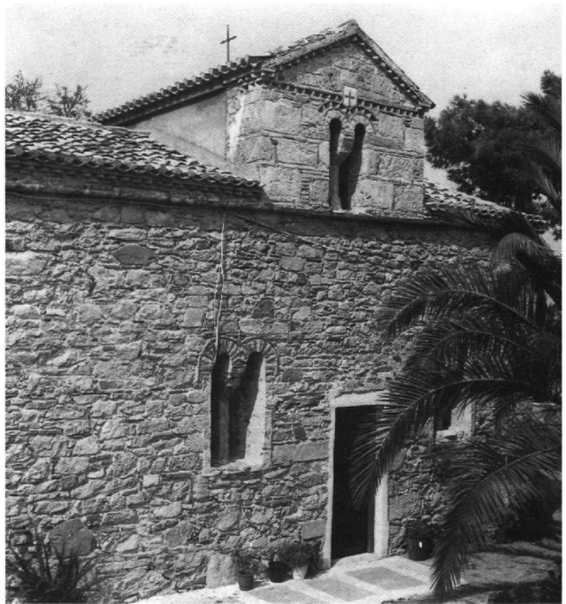
Είκ. 6. Ναός Σωτήρος Γαλαξειδίου. Ή νότια πλευρά από ΝΔ.
