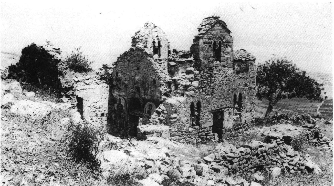
Εικ. 3. Ναός Σωτήρος Γαλαξειδίου. Άποψη άπό ΝΔ. (φωτ. ΧΑΕ 2424).
