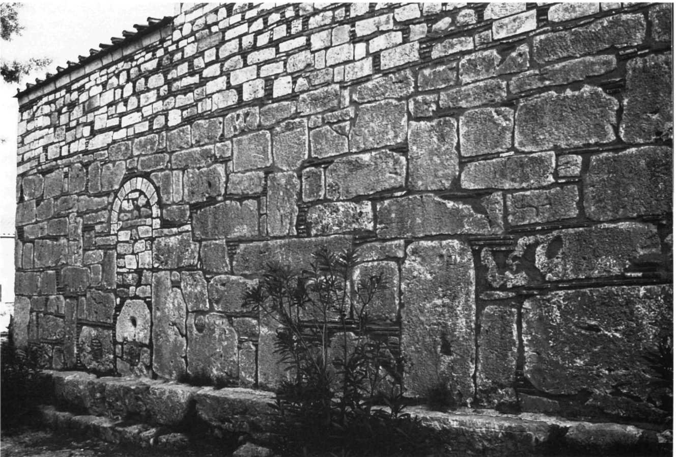
Εικ. 19. Μονή Σαγματά. Καθολικό. Άποψη τμήματος της δόρειας όψης. Διακρίνεται η φραγμένη παλαιότερη πύλη του ιερού.
