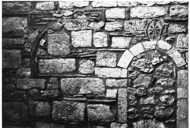
Εικ. 24. Μονή Σαγματά. Άποψη του ανατολικού τοίχου του φωτανάματος.
