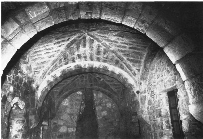
Εικ. 23. Μονή Σαγματά. Άποψη της στέγασης του φωτανάματος.
