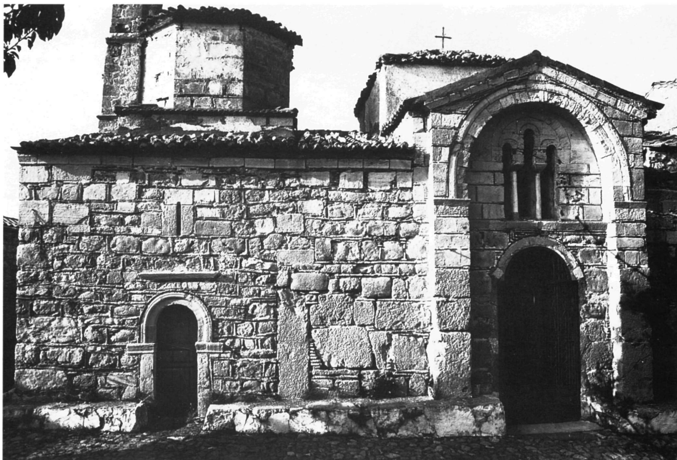
Εικ. 17. Μονή Σαγματά. Καθολικό. Άποψη του δυτικού τμήματος της νότιας όψης. Διακρίνεται ο κατακόρυφος αρμός αλλαγής οικοδομικής φάσεως.
