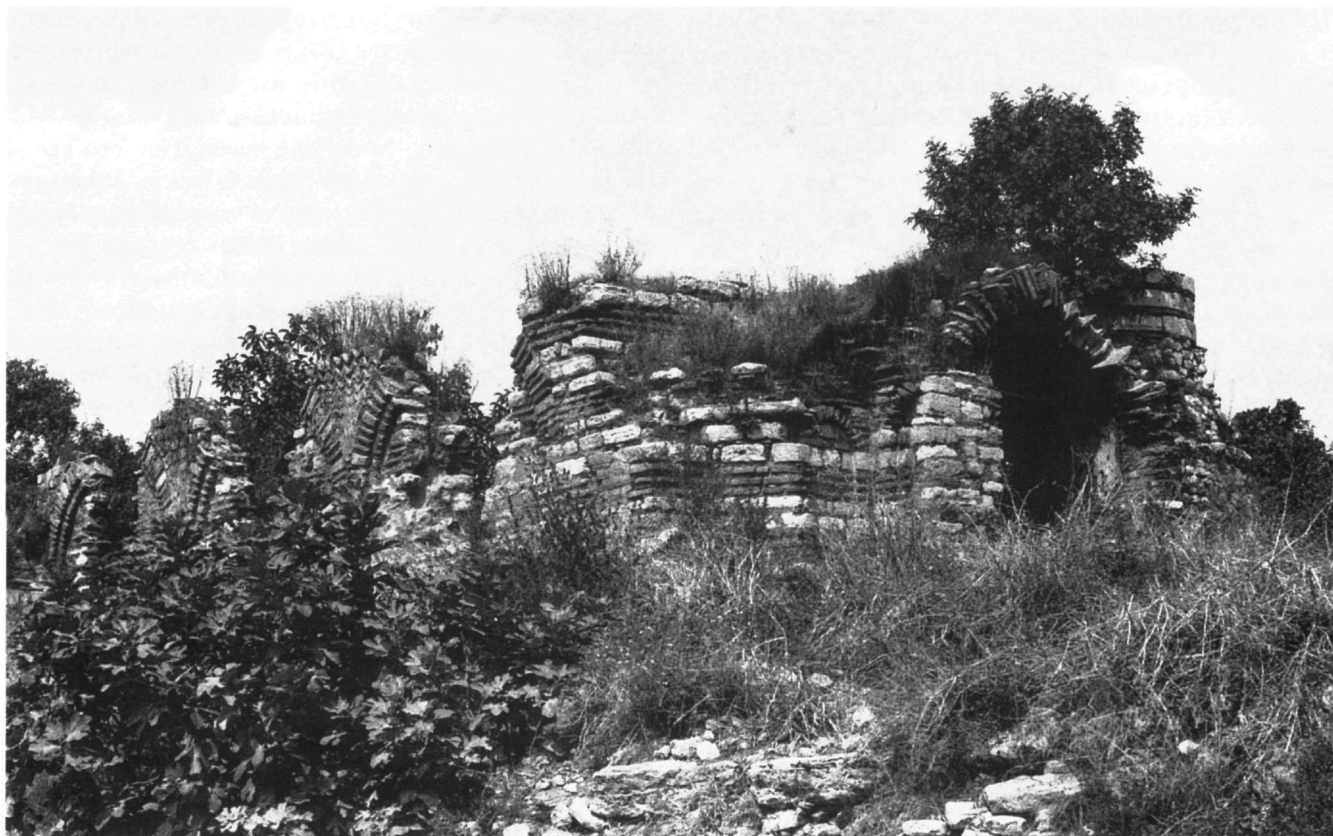
Είχ. 4. Isa Kapisi mescidi. Γενική άποψη από ΝΑ. (φωτ. R. Ousterhout).
