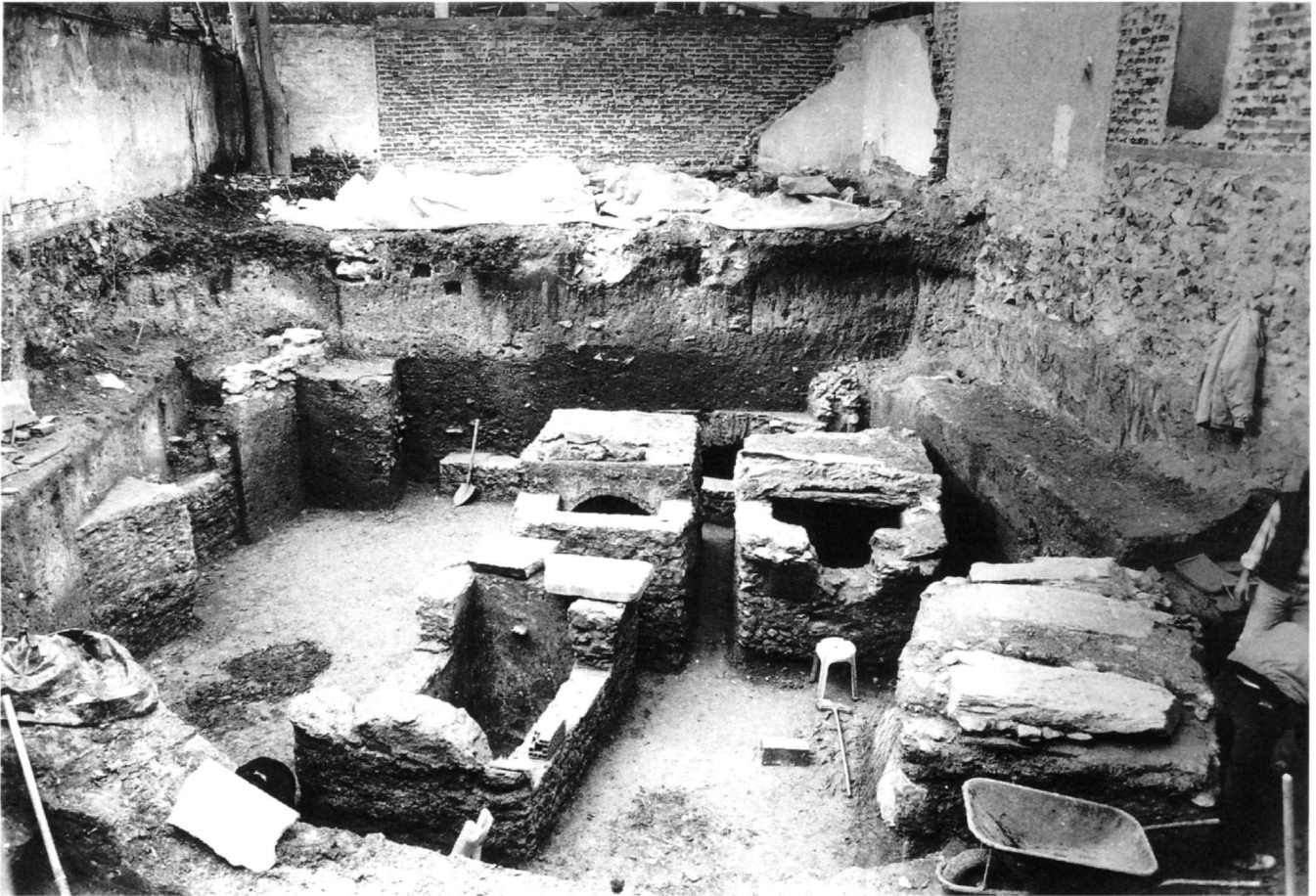
Εικ. 3. Οικόπεδο οδού Δημοσθένους 7. Άποψη τῶν τάφων καὶ τοῦ συγκροτήματος (στό βάθος).
