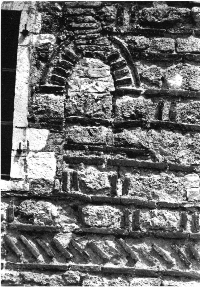
Εἰκ. 17. Μεγάλη Παναγιά. Τὸ μονόλοβο παράθυρο (τεχνημένο σήμερα) στὴ νότια πλευρά.
