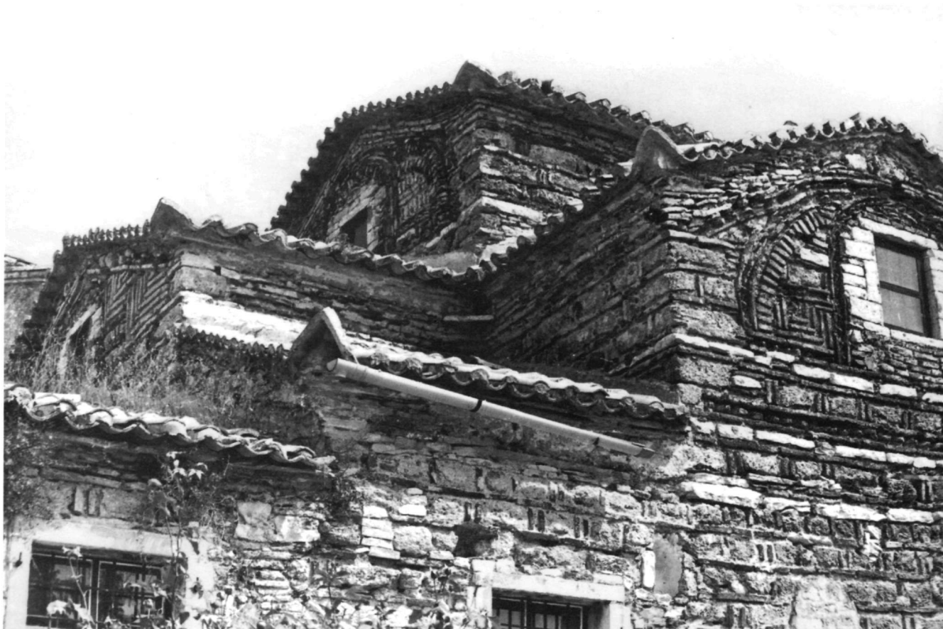
Εἰκ. 14. Μεγάλη Παναγιά. Τὰ παράθυρα στῆ δυτικῇ κεραία τοῦ σταυροῦ καὶ στὸ δυτικὸ ἀέτωμα τῆς τρουλοκαμάρας.
