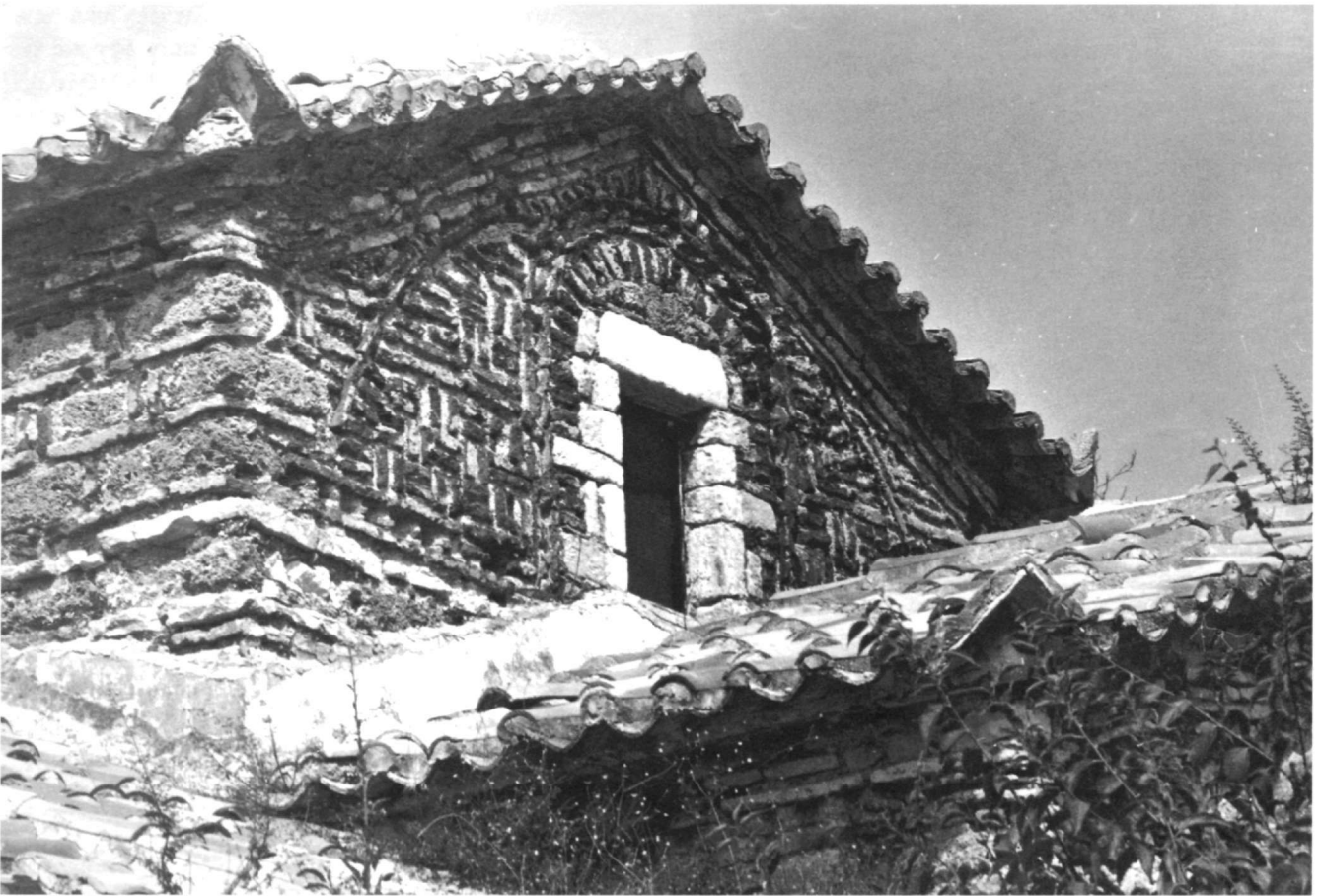
Εικ. 18. Μεγάλη Παναγιά. Ανατολικό τύμπανο τρουλοκαμάρας.
