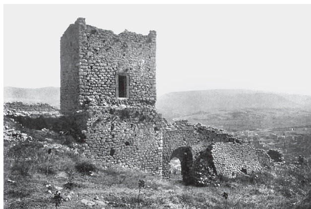
Εικ. 7. Κάστρο Λιβαδειάς. Πύργος και πύλη εσωτερικού περιβόλου. Άποψη από το εσωτερικό (Ρούβιο Υ Λιούκ, Περί Καταλανικών φρουρίων, εικ. 4).
