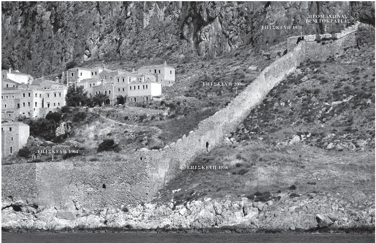
Εικ. 1. Το ανατολικό τείχος. Άποψη από νοτιοανατολικά.
