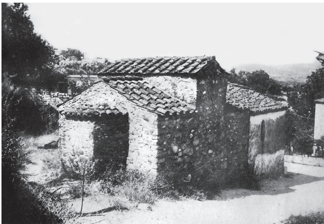
Εικ. 1. Πυργί Εύβοίας, Μεταμόρφωση του Σωτήρος: Άποψη από ΒΑ (Α. Koumoussi).
