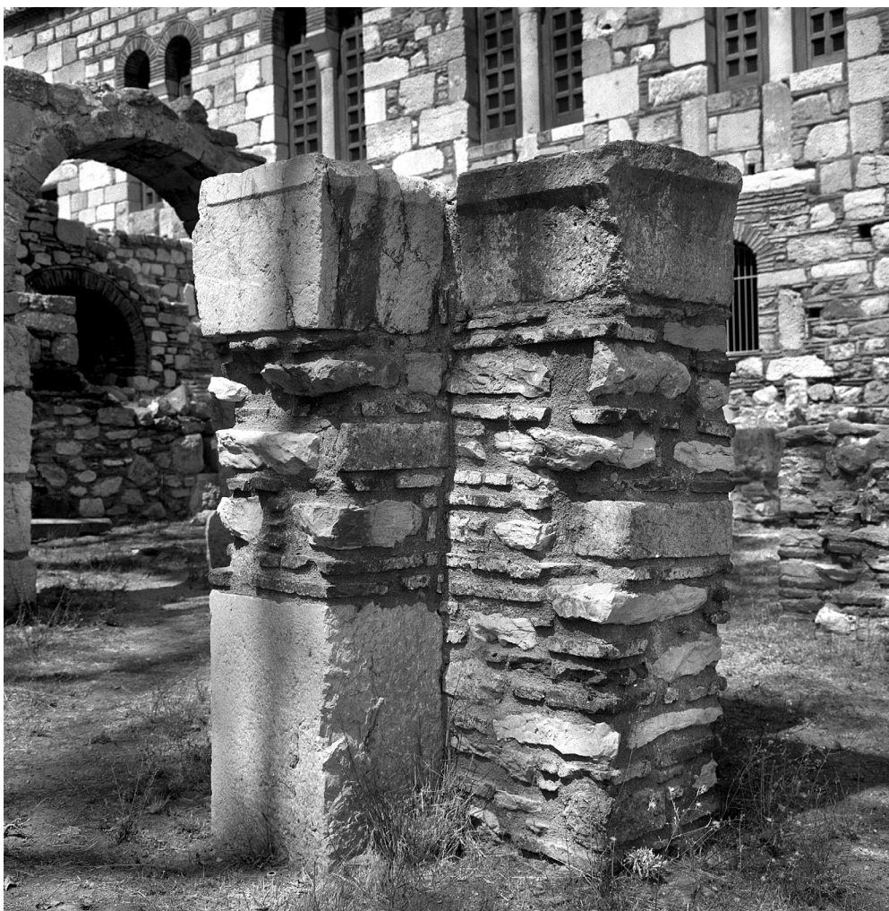
Εικ. 4. Μονή Όσιου Λουκά, νοτιοανατολικό κτήριο. Σταυροειδής πεσσός.
