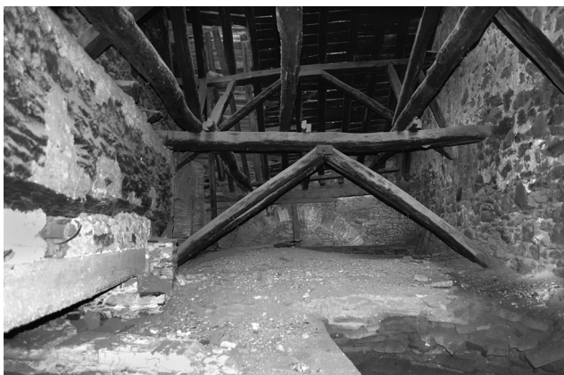
Εικ. 10. Μεγίστη Λαύρα, μαγκιπέιο. Άποψη εσωτερικού στέγης φούρνων προς ανατολικά.
