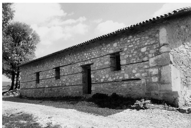
Εικ. 17. Δομένικο Ελλάσσώνας, ναός Αγίου Γεωργίου. Βόρειος τοίχος, άποψη από βορειοδυτικά.
