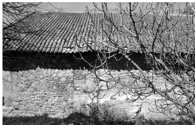
Εικ. 16. Δομένικο Ελλασσώνας, ναός Αγίου Γεωργίου. Ραφή οικοδομικών φάσεων νότιου τοίχου.
