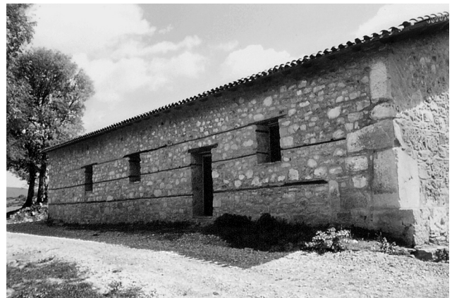
Εικ. 17. Δομένικο Ελλασσώνας, ναός Αγίου Γεωργίου. Βόρειος τοίχος, άποψη από βορειοδυτικά.
