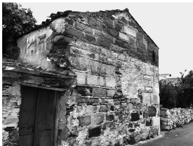
Εικ. 21. Πόλη Χίου, Κάστρο, κτίσμα παρά τον Άγιο Γεώργιο (Κεχρί).
