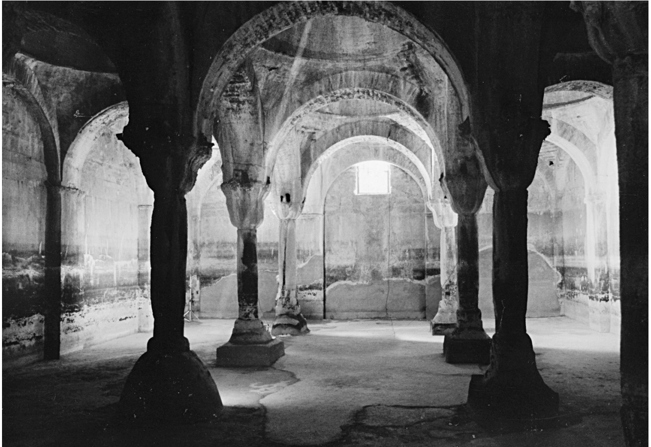
Εικ. 5. Άποψη του εσωτερικού της κινστέρνας.
