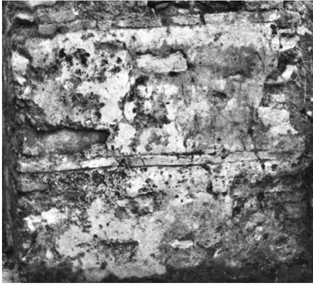
Εικ. 7. Δείγμα τελικής εμφάνισης της τοιχοποιίας της κινστέρνας.
