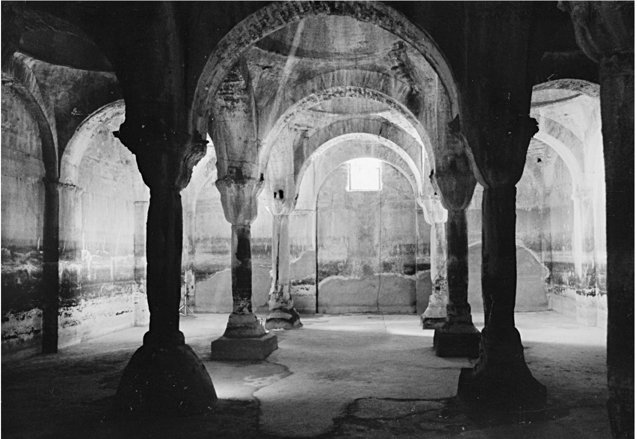
Εικ. 5. Άποψη του εσωτερικού της κινστέρνας.
