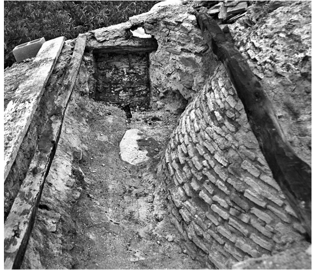
Εικ. 5. Άποψη του εσωτερικού της στέγης. Διακρίνεται στα δεξιά ο τρούλος και απέναντι το φραγμένο άνοιγμα της κρύπτης.
