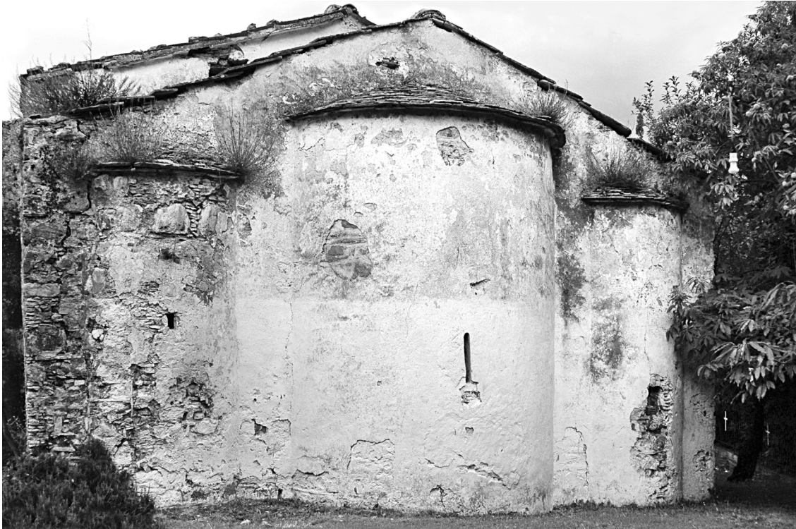
Εικ. 7. Άποψη της ανατολικής όψης πριν από την έναρξη των εργασιών.
