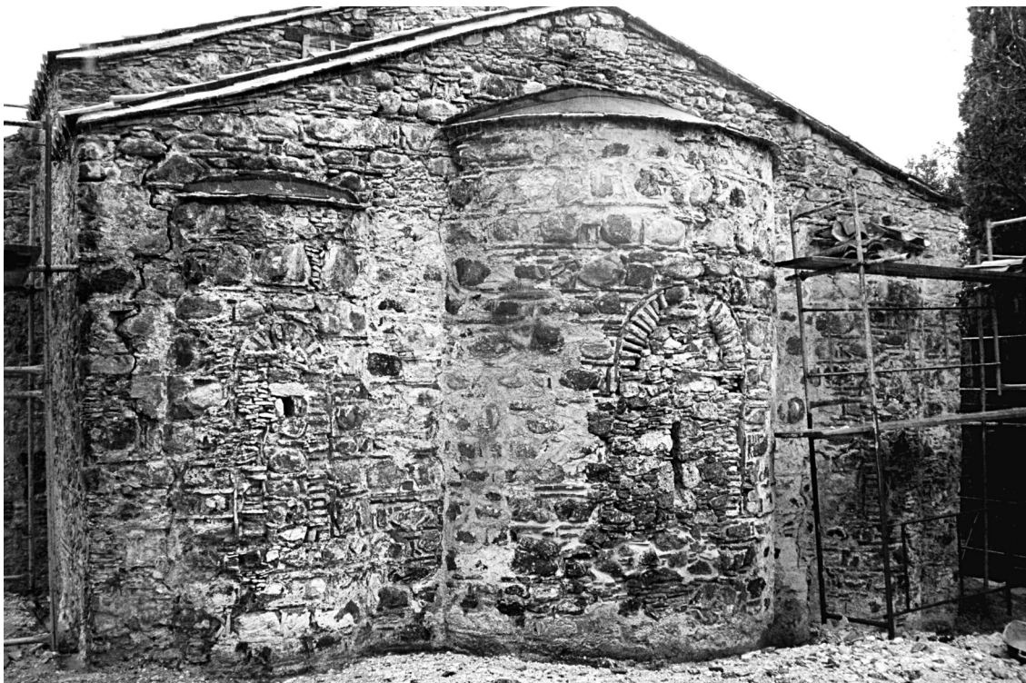
Εικ. 8. Άποψη της ανατολικής όψης μετά την καθαίρεση των επιχρισμάτων.
