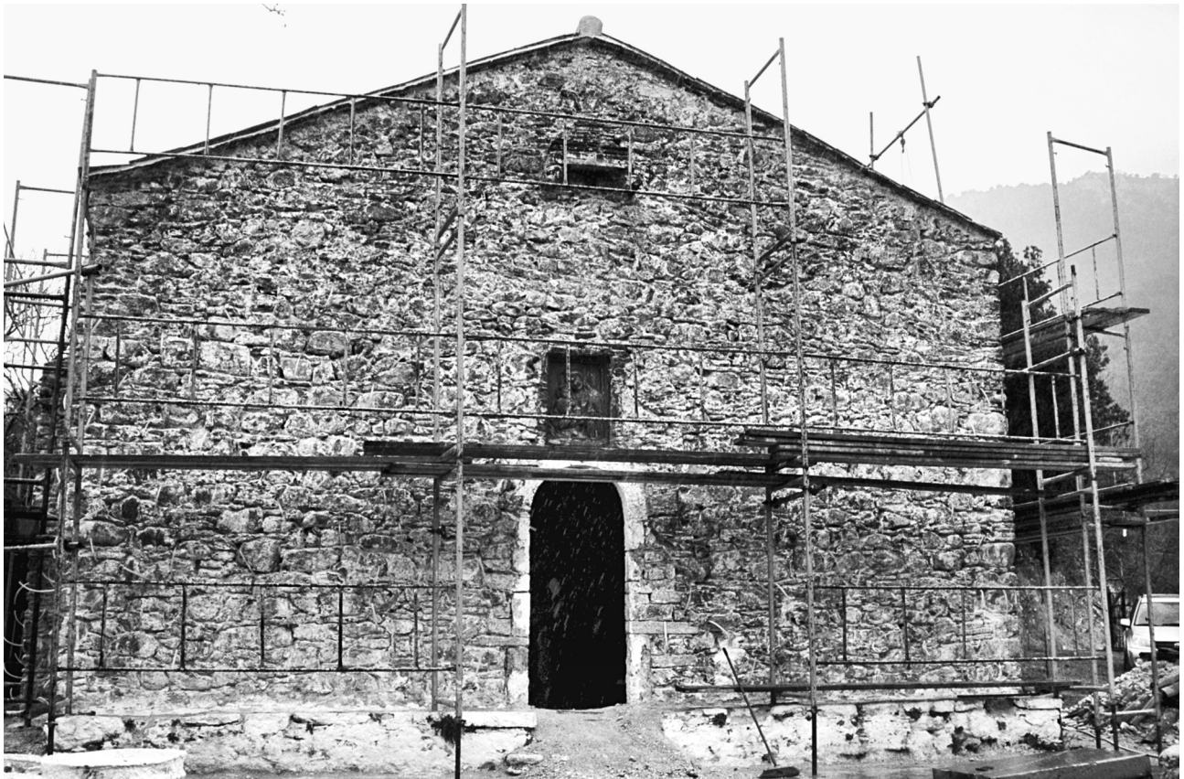
Εικ. 12. Ο δυτικός τοίχος του ναού κατά τις εργασίες.
