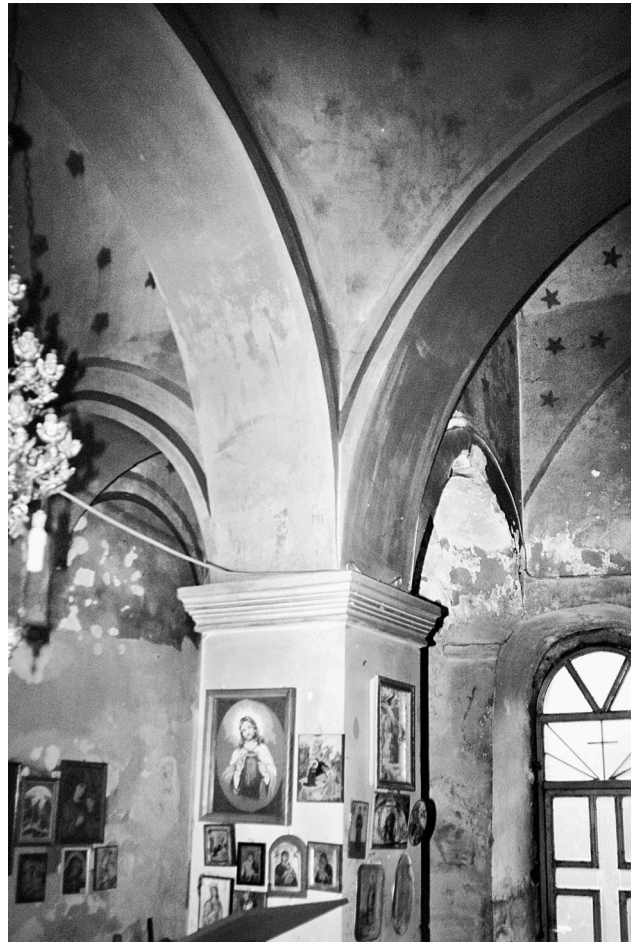
Εικ. 6. Ο νοτιοδυτικός πεσσός του ναού.
