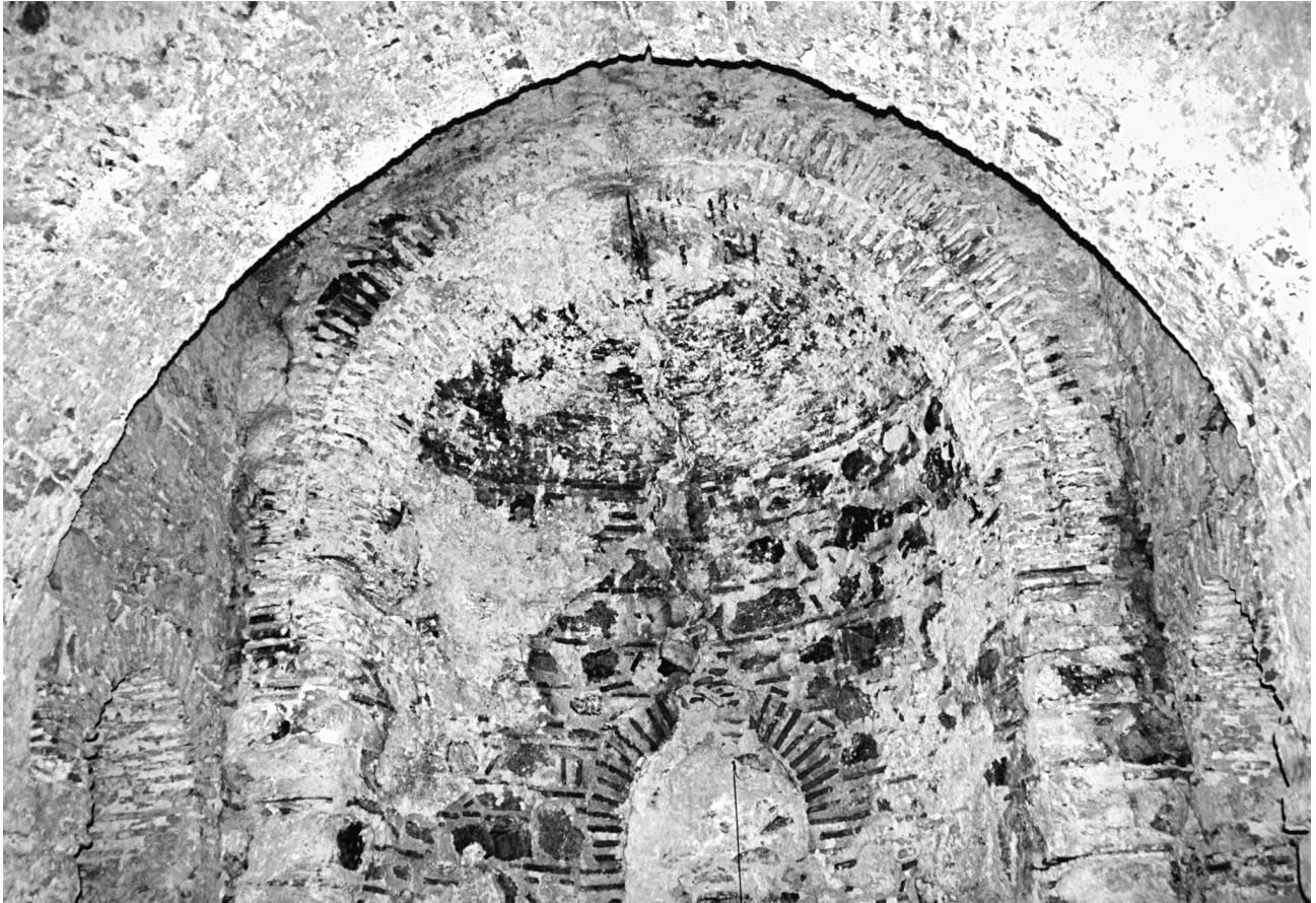
Εικ. 15. Άποψη του εσωτερικού της αψίδας του ιερού. Διακρίνεται η υποχώρηση στο τόξο μετώπου.
