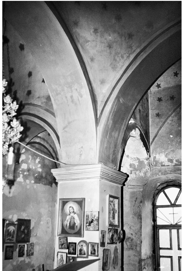
Εικ. 6. Ο νοτιοδυτικός πεσσός του ναού.
