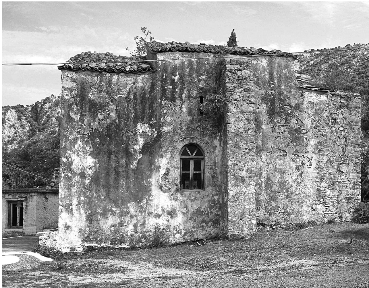
Εικ. 1. Εύβοια, ναός Παναγίας Χιλιαδούς. Άποψη από Ν. πριν από την έναρξη των εργασιών αποκατάστασης.
