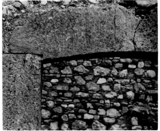
β. Ἅγιοι Ἀπόστολοι. Ἐδρασις ὑπερθύρου ἐπὶ ὀρθοστατῶν. Ὅψις ἐξωτερικῆ τοῦ πρὸς Β. παραθύρου.
