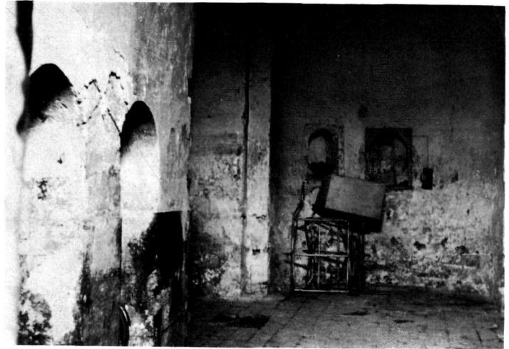
β. Τὸ ἐσωτερικὸν τοῦ νάρθηκος, ὅπου σταθμεύει τὸ βυτιοφόρον τοῦ Δήμου.
