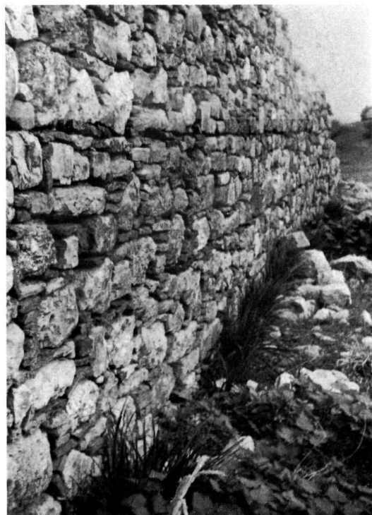
δ. Τοιχοποιία Ν. τοίχου.
