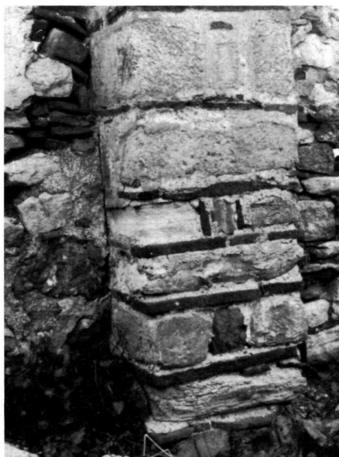
γ. Ή παραστάς τοῦ Δ. τοῖχου ἔνθα καταλήγει ἢ πρὸς Β. κιονοστοιχία. Διακρίνεται ὁ διαφοριστικὸς ἄρμος μεταξύ παραστάδος - Δ. τοῖχου.
