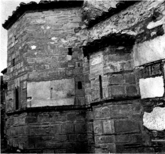
α. Κοίμησις. Ἐνατολική ὄψις. Διάπλασις τοιχοποιίας.
