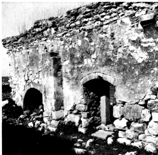
β. Ἐσωτερικὴ ὄψις Β. τοίχου. Διακρίνεται ἡ γένεσις τοῦ θόλου καὶ τοῦ σφενδονίου.
