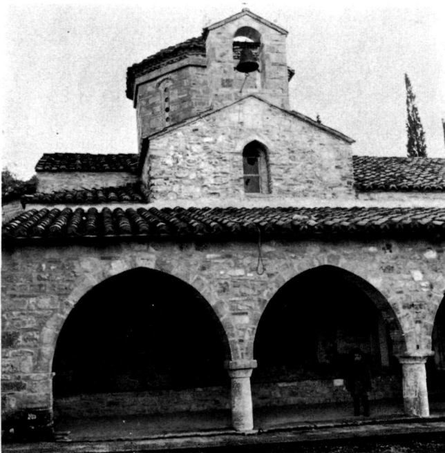
β. Βόρειος ὄψις. Διακρίνεται τὸ νεώτερον κωδωνοστάσιον καὶ ἡ κάτωθεν αὐτοῦ ἐντοιχισμένη ἀνάγλυφος πλάξ. Ἡ στοὰ εἶναι ἔργον προσφάτου ἀναστηλώσεως.
