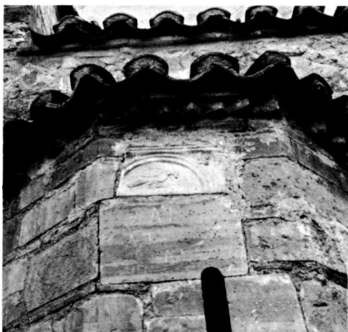
γ. Λεπτομέρειαι τοιχοποιίας καὶ στέψως τῆς προθέσεως.
