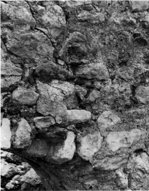
α. Ἅγιοι Ἀπόστολοι. Τοιχοποιία Β. τοίχου.
