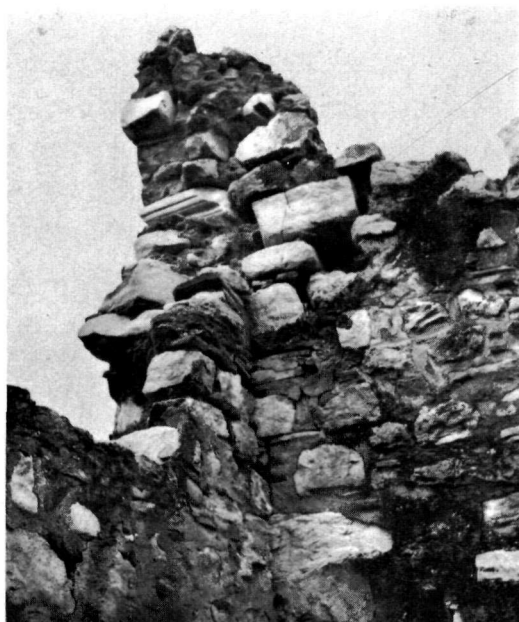
β. Άσύνδετος ΒΔ. γωνία του ναού. Διακρίνεται κλασσικόν έντοιχισμένον.
