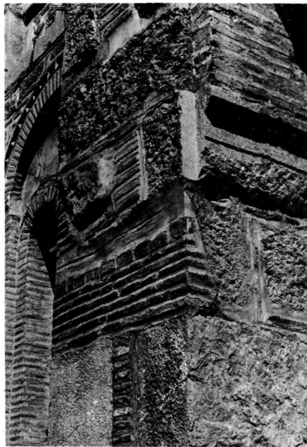
Εικ. 2. Ὑπόλειμμα ἐγκαρσίου τόξου τοῦ κατεδαφισμένου ἐξωάρθηκα.
