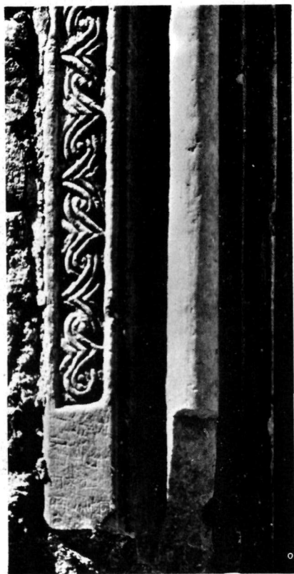
Εικ. 1. Τμήμα από τὸν ἀριστερὸ ὀρθοστάτη τοῦ θυρώματος τοῦ ἐξωνάρθηκα, ἐνσωματωμένο στὸ ἄνοιγμα τοῦ κωδωνοστασίου.
