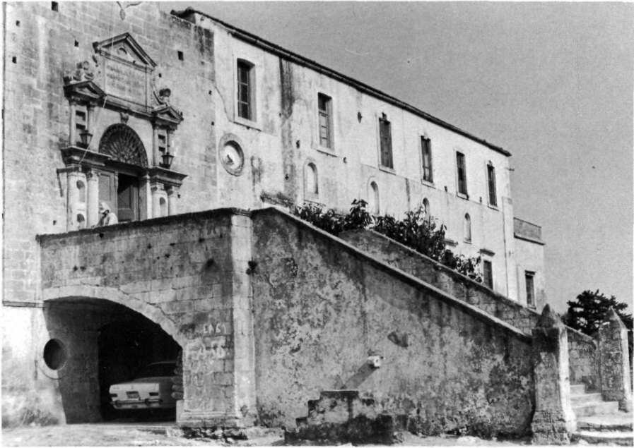
1. Ἁγία Τριάδα τῶν Τζαγκαρόλων. Ἡ μεγάλη σκάλα, τὸ θύρωμα τῆς εἰσόδου καθὼς καὶ τὸ νότιο τμήμα τῆς δυτικῆς πλευρᾶς τοῦ μοναστηριοῦ.
