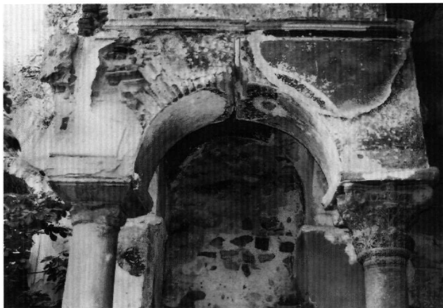
Εικ. 12. Τρίγλεια. Ναός Παντοβασίλισσας. Η θολοδομία του βορειοδυτικού γωνιακού διαμερίσματος (Ιούλιος 2001).
