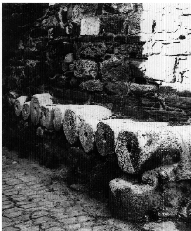
Εικ. 18. Τρίγλεια. Ναός Παντοβασίλισσας. Η θεμελίωση της ανατολικής πλευράς του ναού (Ιούλιος 2001) (φωτ. Χ. Μπούρας).
