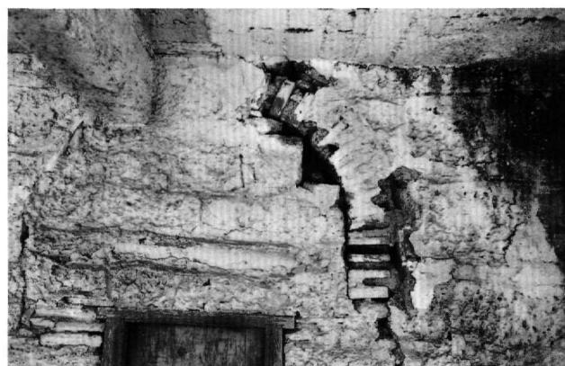
Εικ. 4. Το πλίνθινο τόξο του αρχικού ανοίγματος στη νότια όψη του ναού.
