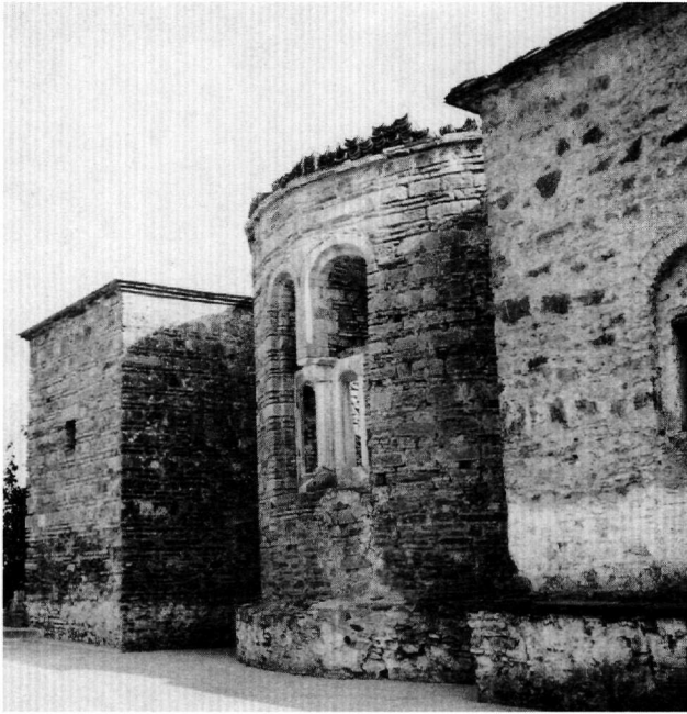
Εικ. 9. Καθολικό μονής Αγίου Δημητρίου Στομίου. Μερική άποψη της βορείας πλευράς.
