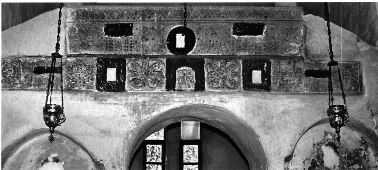
Εικ. 9. Ανδρομονάστηρο Μεσσηνίας. Τμήματα επιστυλίων εντοιχισμένα στο μεταγενέστερο κτιστό τέμπλο του καθολικού.
