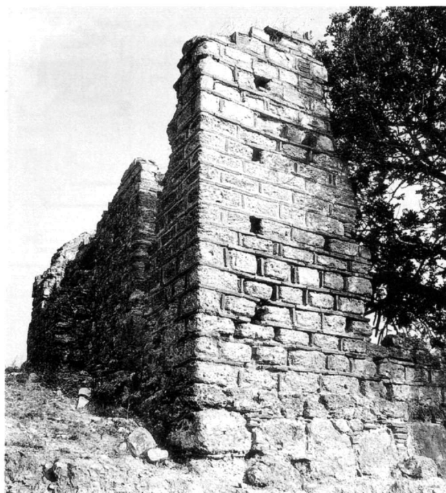
Εἰκ. 7. Ἅγιος Γεώργιος Σταμνᾶς. Τό βόρειο τμήμα τῆς δυτικῆς πλευρᾶς.
