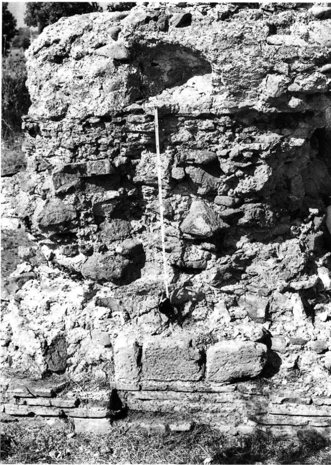
Εικ. 2. Τραιανούπολη, υστεροβυζαντινός ναός. Λεπτομέρεια της τοιχοποιίας στη βόρεια πλευρά.
