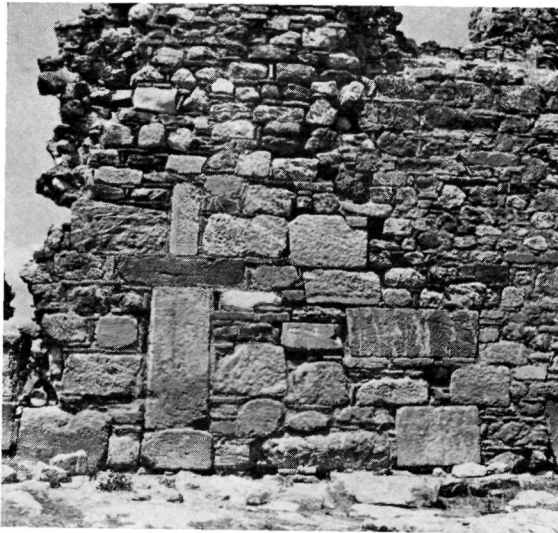
β. Δείγμα τοιχοποιίας νοτίου τείχους.
