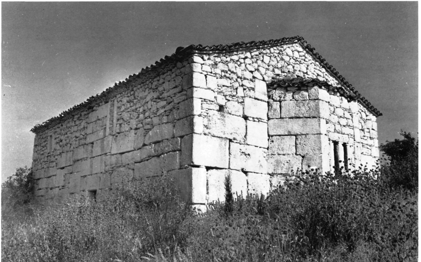
Εἰκ. 1. Ραχιώτισσα Φλιοῦντος. Γενική ἄποψη τοῦ ναοῦ ἀπό τά νοτιοανατολικά.
