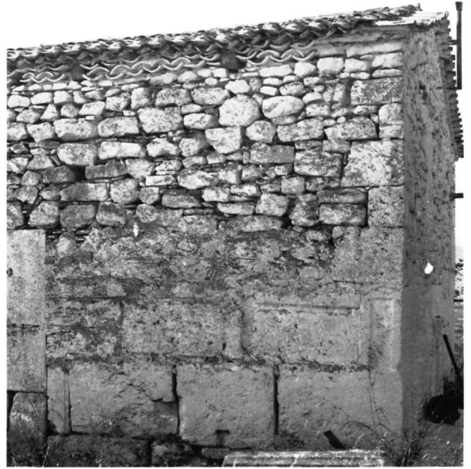
Είκ. 3. Ραχιώτισσα Φλιοῦντος. Τμήμα τῆς βορείας πλευρᾶς τοῦ μνημείου μέ ἐνδειξη τῆς ἀρχικῆς καὶ τῆς νεωτέρας τοιχοποιίας τῆς.
