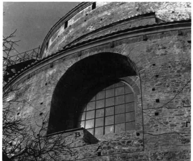
Εικ. 26. Η βάση του νότιου παραθύρου μετά την πρόσκαιρη αφαίρεση της εξωτερικής επίχωσης.
