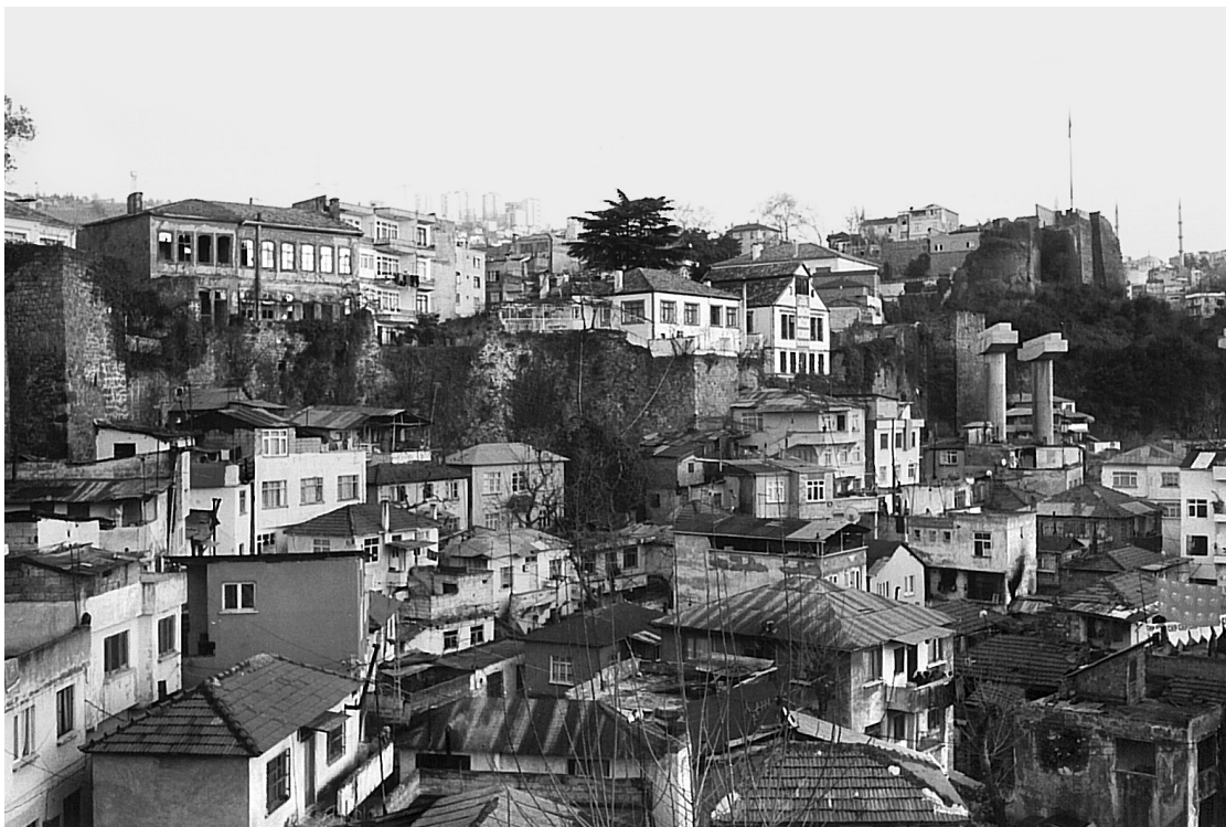
Fig. 3. La partie ouest de l'enceinte byzantine de Trébizonde (photo P. Androudís, 2004).
