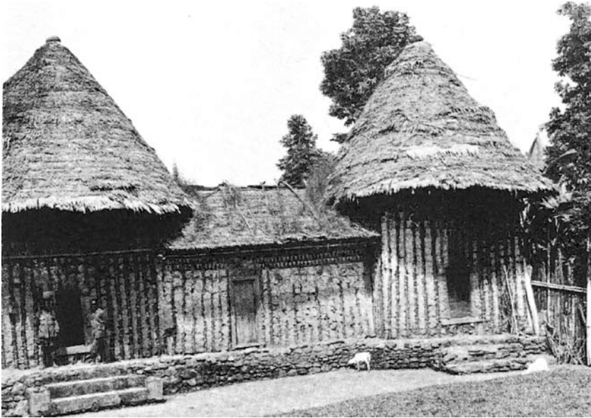
Η είσοδος του «οικισμού» ενός προύχοντα στο Bangwa-Fontem (περιοχή Bamiléké, νοτιοδυτικά Grassfields) (Πηγή: Brain 1972: 55)
