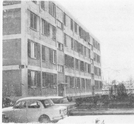
Τυπικὴ πρόσοψις πολυκατοικίας τοῦ νέου οἰκισμοῦ μετὰ τὴν δευροφύρτευσιν
