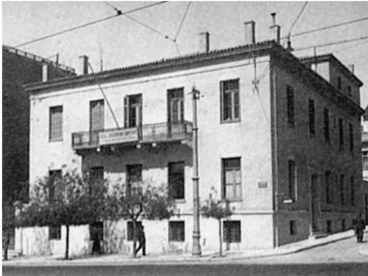
Οἰκία Ρώτα, πρωθυπουργικὴ κατοικία τοῦ Ἰω. Κολέττη (1844-1847), πρὶν ἀπὸ τὴν κατεδάφισή της (Κώστας Η. Μπίρης, Αἱ Ἀθήναι... , ἔ.π., σ. 99)
