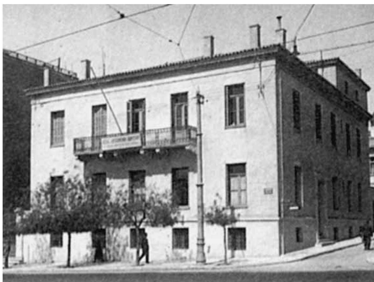
Οἰκία Ρώτα, πρωθυπουργικὴ κατοικία τοῦ Ἰω. Κολέττη (1844-1847), πρὶν ἀπὸ τὴν κατεδάφισή της (Κώστας Η. Μπίρης, Αἱ Ἀθήναι... , ἔ.π., σ. 99)
