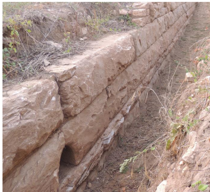
Εικ. 8. Τοξωτό άνοιγμα στο ανατολικό τείχος.
