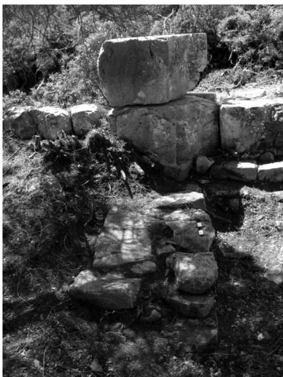
Εικ. 13: Η θεμελίωση του τοίχου της πρόσοψης του ναού της ακρόπολης.
