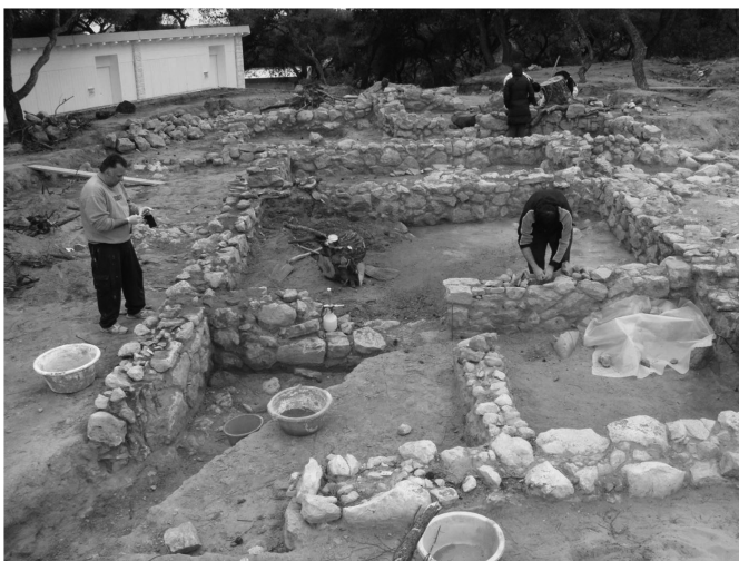
Εικ. 16ζ. Το δεύτερο κλασικό κτίριο στο σκάμμα 3 μετά την κοπή των δέντρων.
