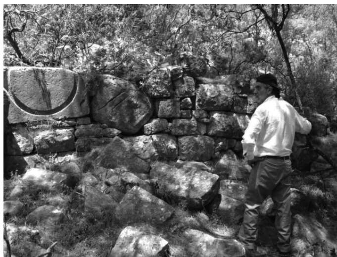
Εικ. 113: Καμπάνες, αναλημματικός τοίχος με εντοιχισμένο λίθο ελαιοπιεστηρίου.
