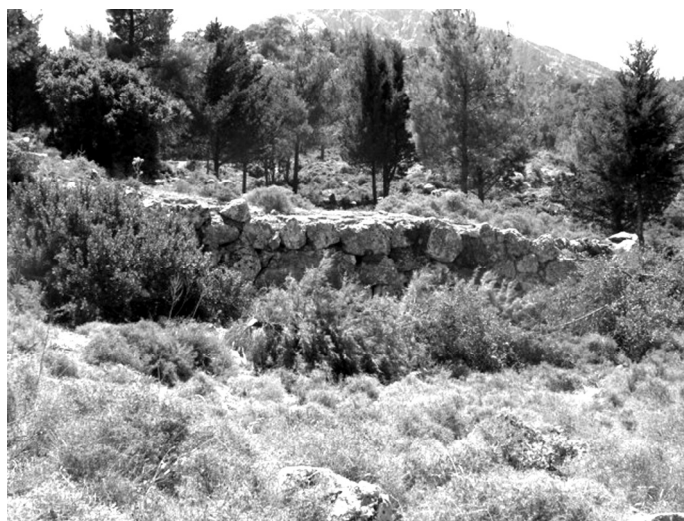
Εικ. 103: Αλώνια, αναλημματικός τοίχος πολυγωνικής τοιχοδομίας.
