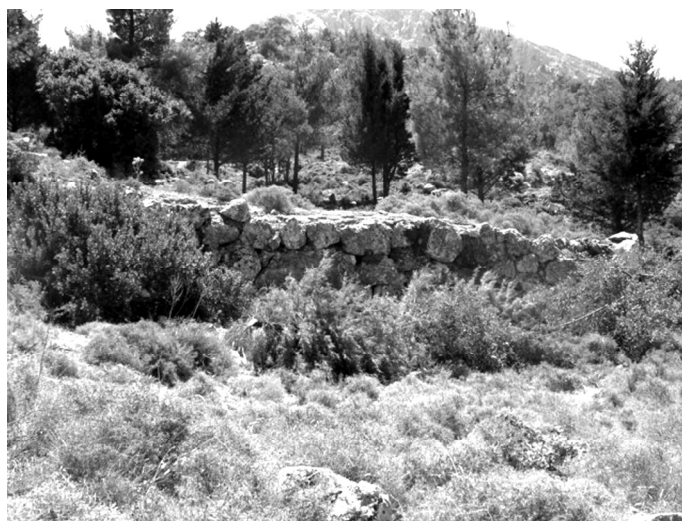
Εικ. 103: Αλώνια, αναλημματικός τοίχος πολυγωνικής τοιχοδομίας.
