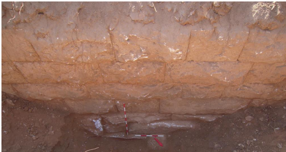
Εικ. 6. Θεμελίωση τείχους.
