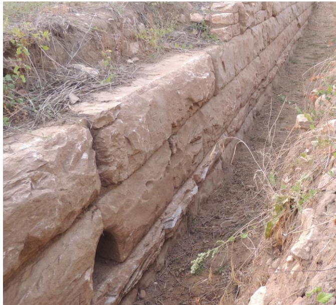
Εικ. 8. Τοξωτό άνοιγμα στο ανατολικό τείχος.
