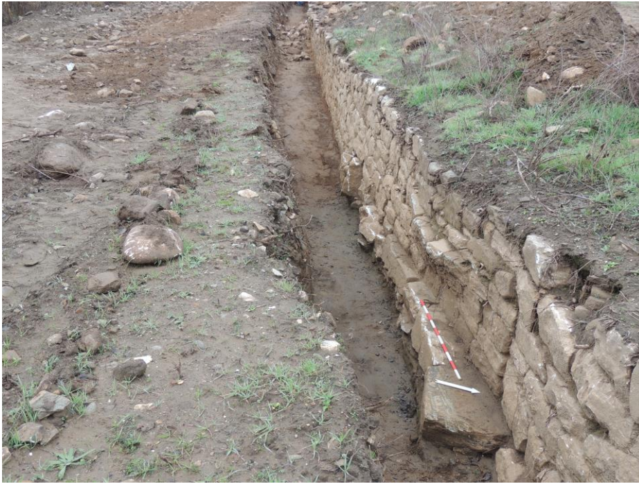
Εικ. 13. Προεξοχή στο νότιο σκέλος της οχύρωσης.
