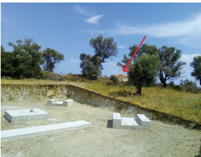
Εικόνα 3. Η οικία που φαίνεται με κόκκινο βέλος στη φωτογραφία συνορεύει με το κτήμα όπου θα εγκατασταθεί ο Σταθμός.
