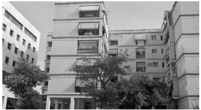
Εικόνα 5: Τμήμα του συγκροτήματος κοινωνικής κατοικίας (αρι- στερά διακρίνεται η πίσω πλευρά της Σχολής Δημόσιας Διοίκησης) στη θέση των παλαιών προσφυγικών πολυκατοικιών στον Ταύρο. Πηγή: Προσωπικό αρχείο.
