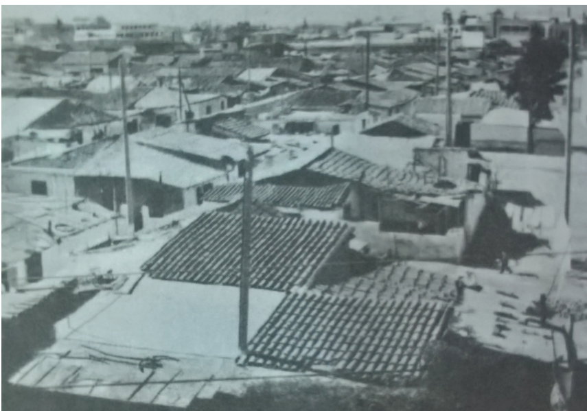
Εικόνα 1β: Η παραγκούπολη της «Παναγίτσας» πριν την κατεδάφιση των παραπηγμάτων. Πηγή: Σούτος 1983:150.
