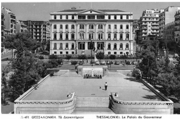
Εικ.1. Η πλατεία διοικητηρίου πριν ακόμα γκρεμιστεί προκειμένου να δημιουργηθεί το υπόγειο πάρκινγκ.
