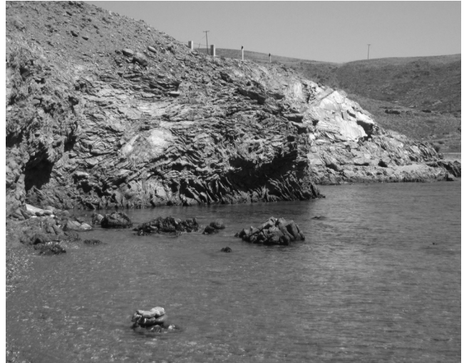
Φωτογραφία 1: Παράκτιος Κρημνός σε φλύσχη στη περιοχή του Στενού
