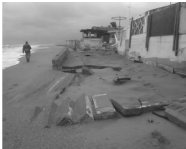
Σχήμα 6: Χαρακτηριστική περίπτωση κατεστραμμένης περιφραξης κατοικίας από το χειμérico κύμα σε περιοχή μεταξύ των τομών 8 και 9.
