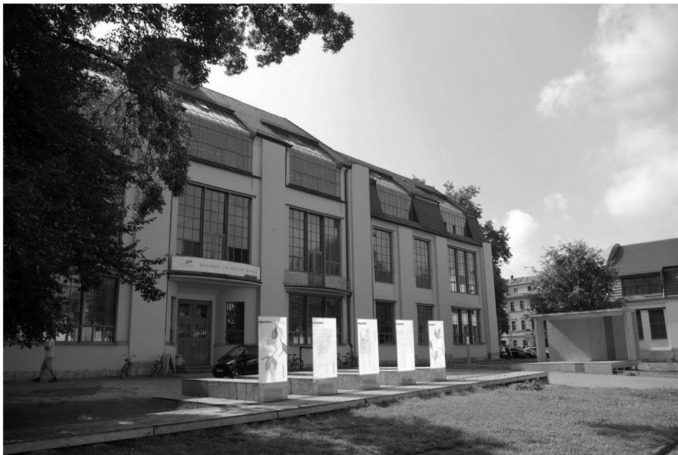
Εικόνα 2: Το ιστορικό κεντρικό κτίριο του Bauhaus-Universität Weimar, που κτίστηκε την περίοδο 1904–1911 και σχεδιάστηκε από τον Henry van de Velde, όπου έλαβε χώρα το συνέδριο.
