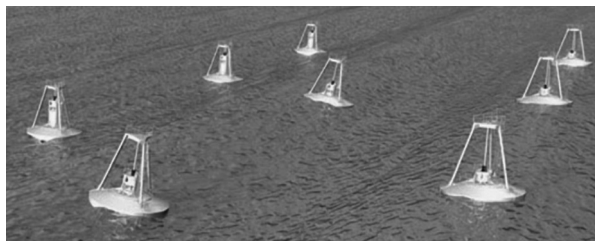
Εικόνα 6: Τυπική διάταξη συστοιχίας σημειακών απορροφητήρων κυματικής ενέργειας, εν είδη πάρκου κυματικής ενέργειας.
