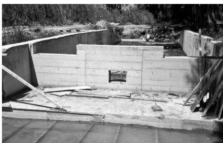
Εικόνα 2. Ολυμπιακές κατασκευές στο κανάλι της μακαρίας πηγής (Καλοκαίρι 2002, Ε. Αποστολοπούλου)
