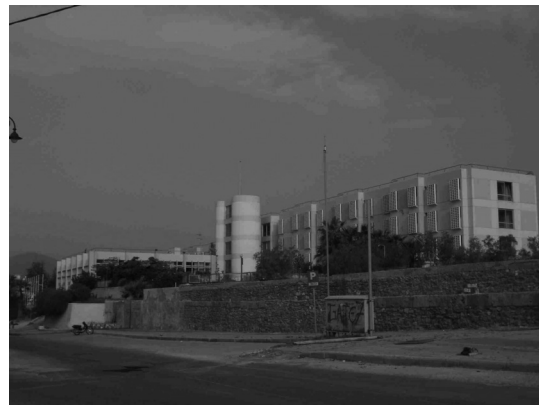
Εικόνα 2: Η θερμαλιστική εγκατάσταση (υδροθεραπευτήριο) του ΕΟΤ στα Λ. Αιδηψού
