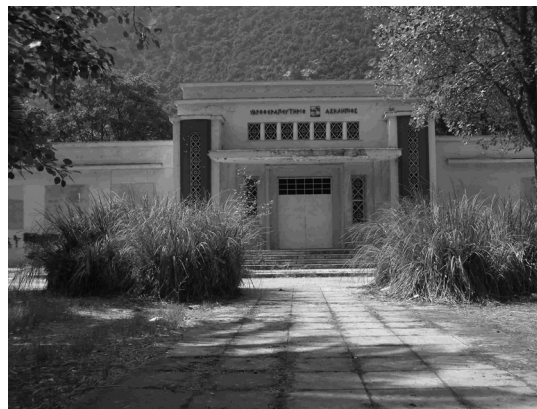
Εικόνα 4: Η εγκαταλελειμμένη θερμαλιστική εγκατάσταση (υδροθεραπευτήριο) «Ασκληπιός» στα Κ. Βούρλα
