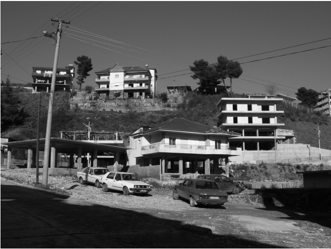
Εικόνα 5: Αυτοστέγαση στο Αργυρόκαστρο. Η κατασκευή των κατοικιών στηρίζεται σε προσωπική εργασία των ιδιοκτητών.
