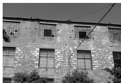
Φωτογραφία 3: Πίσω όψη του βιομηχανικού συγκροτήματος ΧΡΩΠΕΙ
