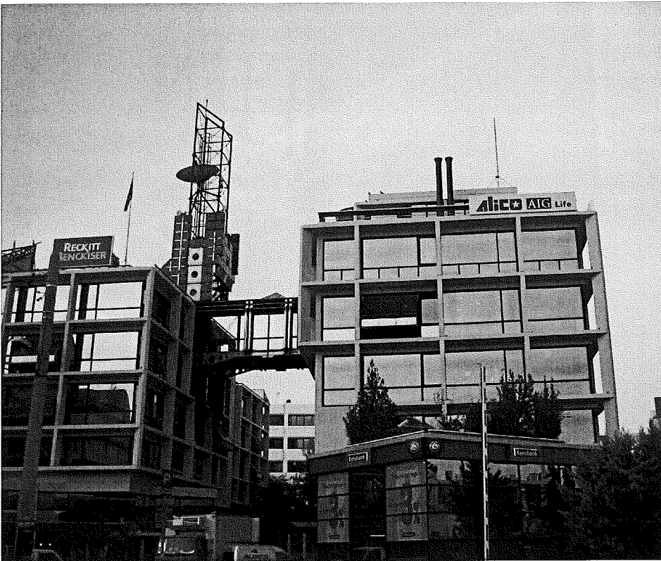
Εικόνα 1. Εμπορικό κέντρο πρώτης γενιάς που μετατράπηκε σε χώρους γραφείων στη Λεωφ. Κηφισίας
