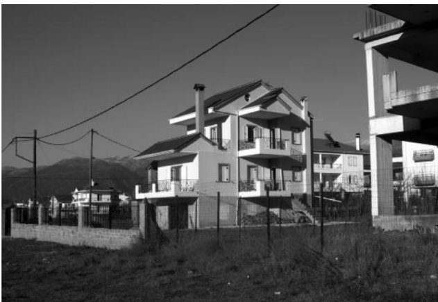
Εικόνα 3: Μονοκατοικία σε περιοχή νέας επέκτασης του σχεδίου πόλης.
