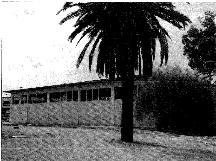
Οι εγκαταστάσεις του κέντρου ΣΕΙΣΜΟΠΟΛΙΣ στο Δήμο Αγ. Ιωάννη Ρέντη
