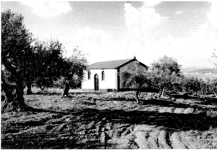
Ελαιώνας της περιοχής: η κατάσταση πριν τις επεμβάσεις
